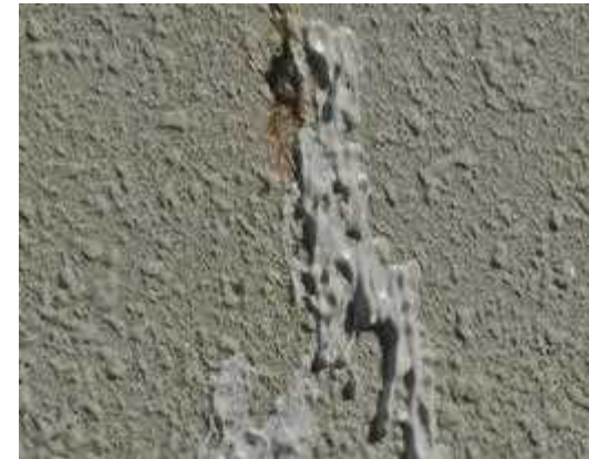
防錆／防水処理
