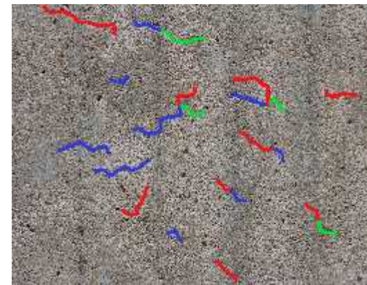
A I による外壁検査
